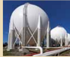
Armazenamento de substâncias químicas e materiais inflamáveis
