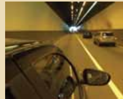
Túneis ferroviários e rodoviários
