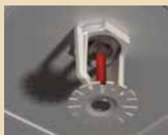
Sistema de sprinklers de alta pressão
